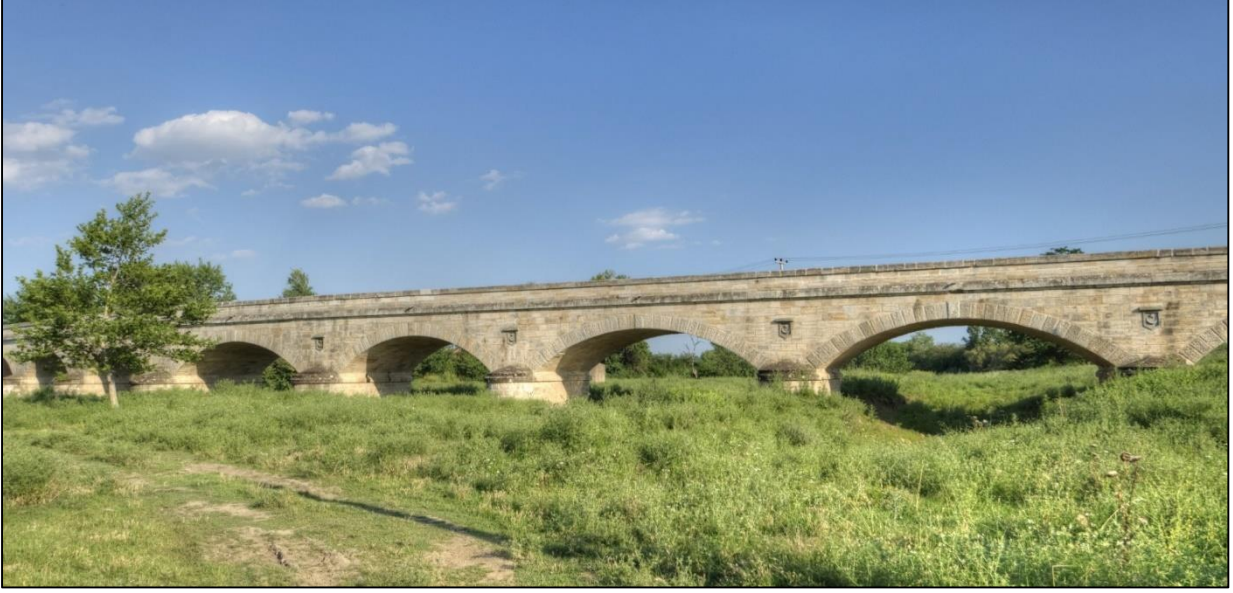
Fotoğraf -30 Gazimihal Köprüsü
