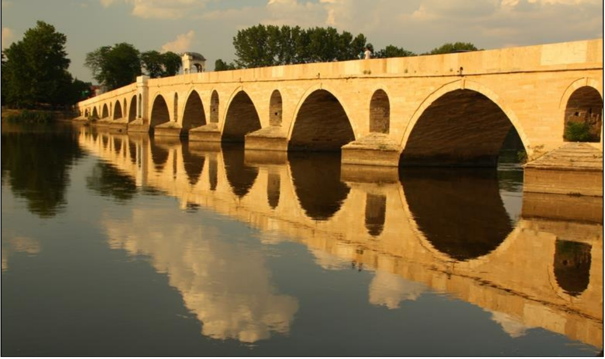
Fotoğraf -19Meriç Köprüsü
